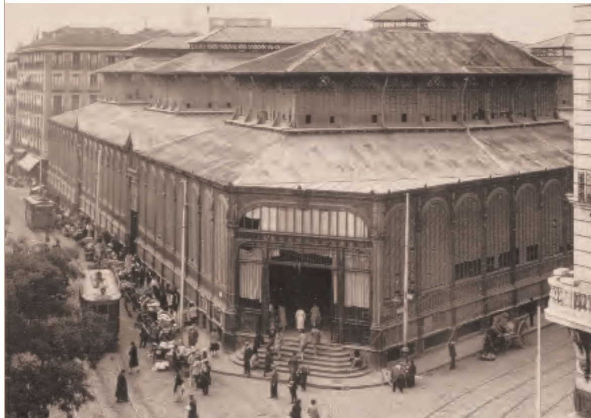
Mercado de la Cebada, la primera arquitectura de hierro en Madrid. Ferriz. h 1929. Ayuntamiento de Madrid. Museo de Historia.
