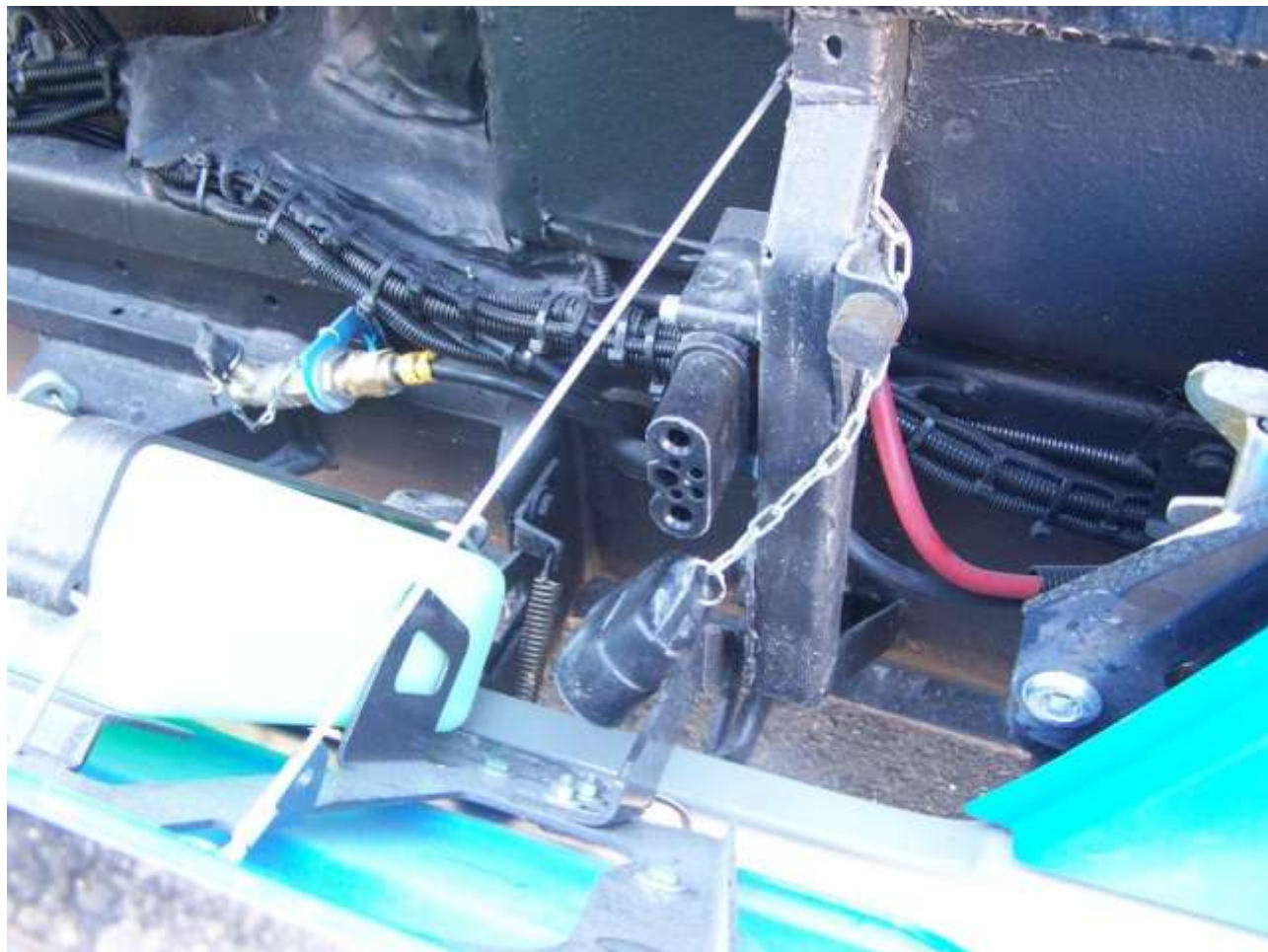
(Conector rápido de baterías con tapa desmontada detrás del portón frontal)
